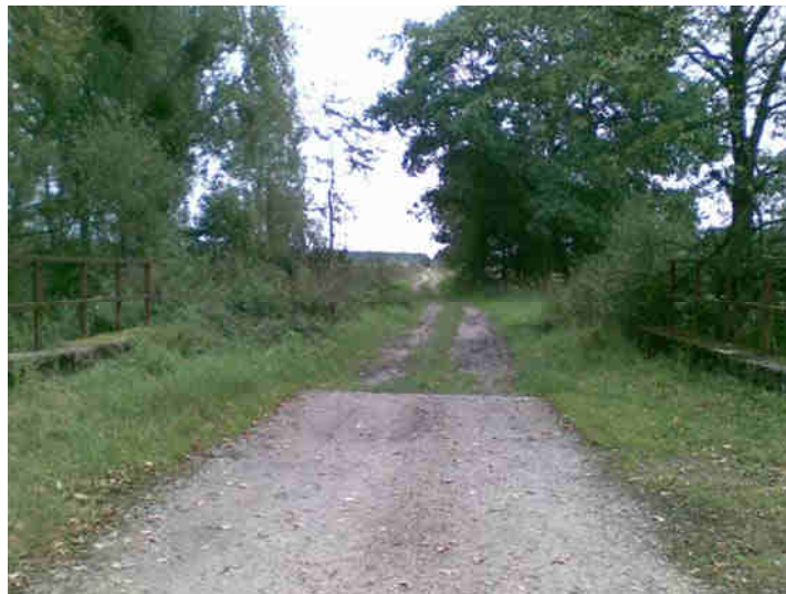
Figure 11 : Vue de l'ancienne voie ferrée prise au niveau du pont enjambant la Dormoise
