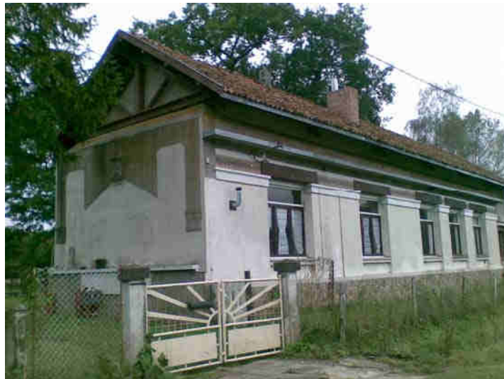
Figure 10 : Maison blockhaus d'Autry située près de la gare
