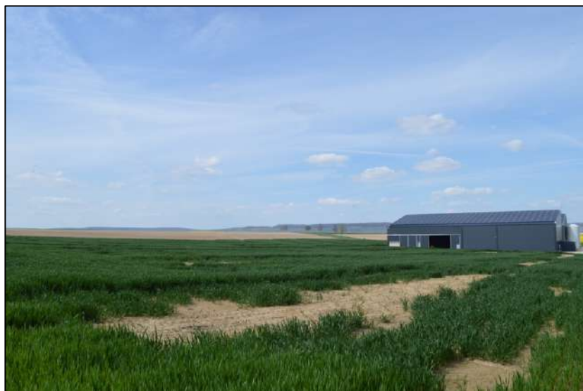
Figure 48 : Vue du bâtiment agricole et du site d'étude – (Source : AdT)
