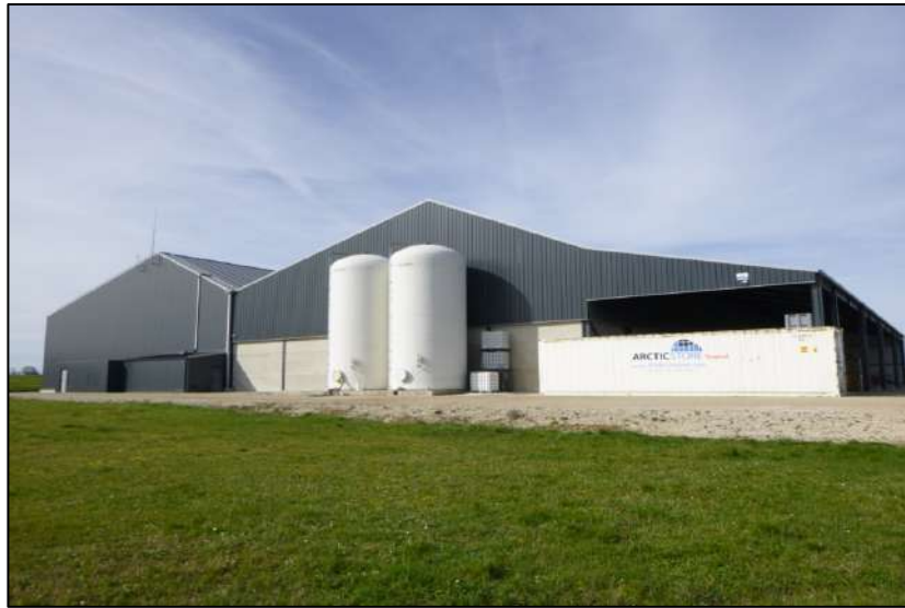
Figure 47 : Vue du bâtiment agricole situé en contrebas du site d'étude – (Source : AdT)
