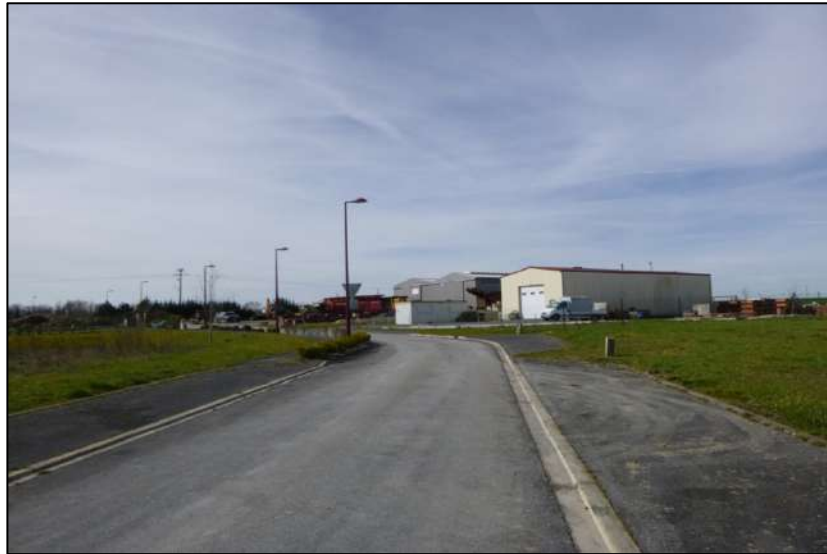
Figure 49 : Vue sur la zone artisanale depuis la RD34 – (Source : AdT)
