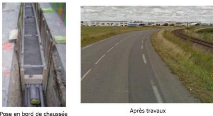
Figure 9 : Exemple de pose en fourreaux PVC sous voirie d'une liaison souterraine à un circuit (RTE)
