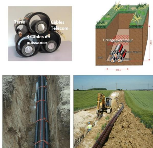
Figure 8 : illustration de pose en fourreaux PEHD d'une liaison souterraine à un circuit (RTE)
