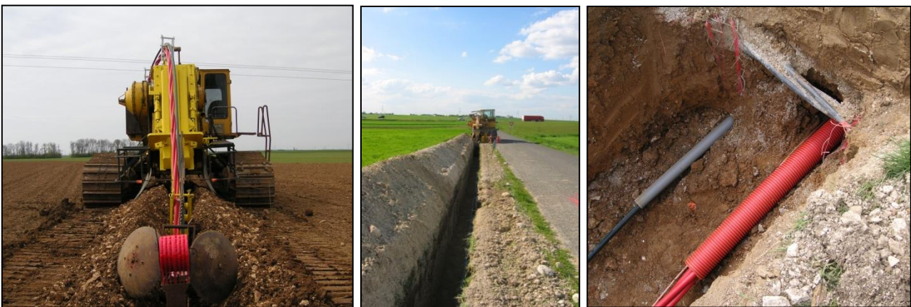
Figure 17 : Photos illustrant l'installation du câblage interne – Source : NORDEX
