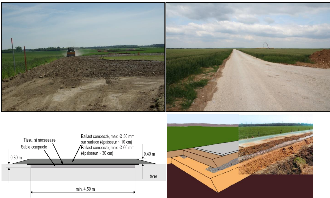
Figure 12 : Photos et schémas illustrant la préparation des voies d'accès – Source : NORDEX
