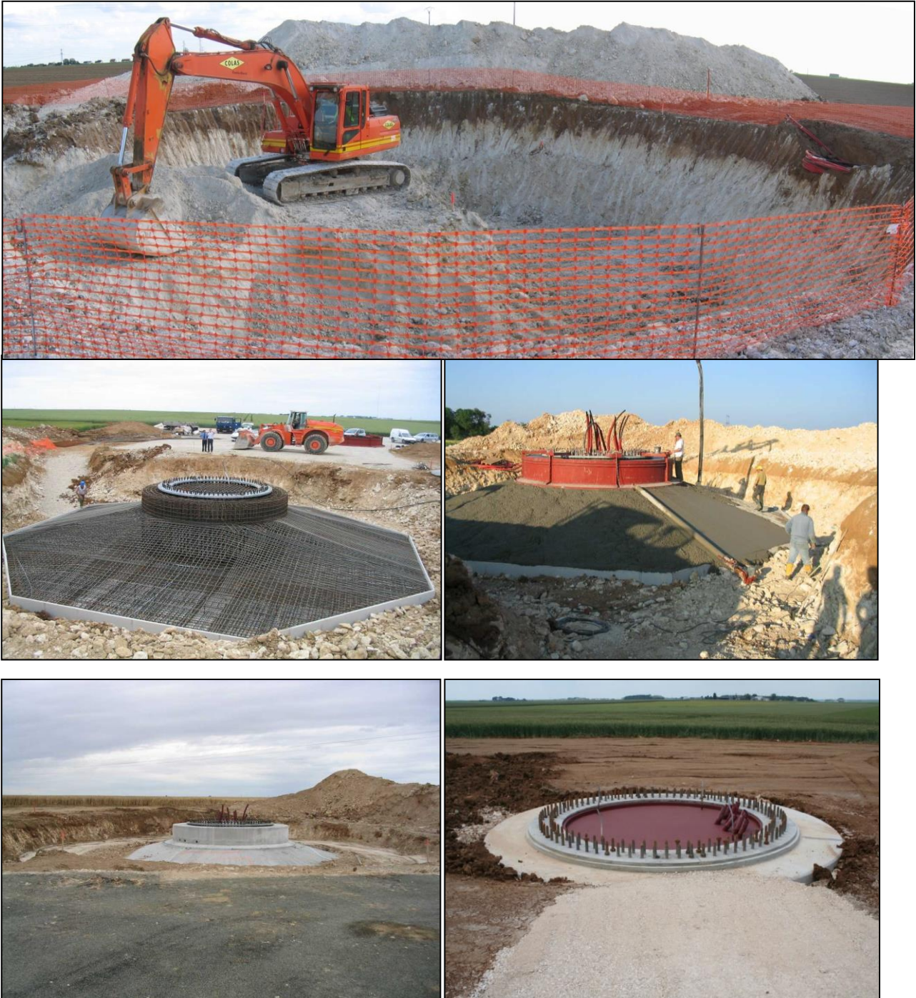
Figure 13 : Photos illustrant les étapes de la réalisation d'une fondation – Source : NORDEX
