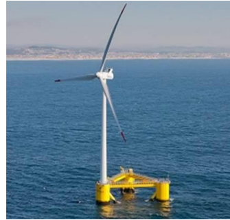
Figure 1 : Prototype d'éolienne flottante mise en service au Portugal par EDPR
