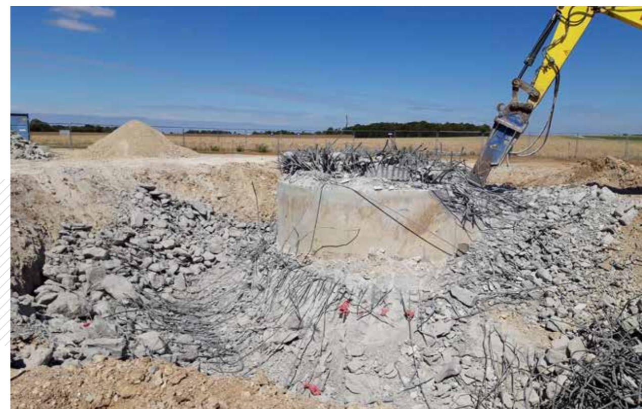
Figure 69 : Démantèlement des fondations d'une éolienne sur un parc EDPR (source : EDPR)
