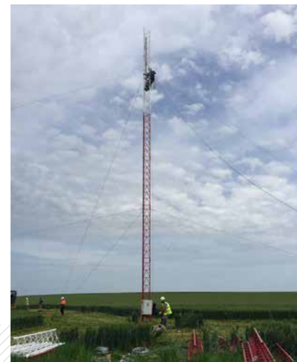
Figure 36 : Installation du mât de mesure de Fromentières
