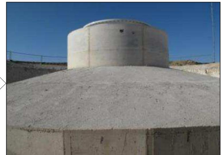
Les fondations types sont circulaires et se composent d'une semelle de 22 à 25 m de diamètre sur 2,5 à 4,4 m de profondeur. La fixation du mât est assurée par un double boulonnage à la base sur les ancrages en tiges filetées formant une « cage d'écureuil » noyées sur toute la hauteur dans le massif.
