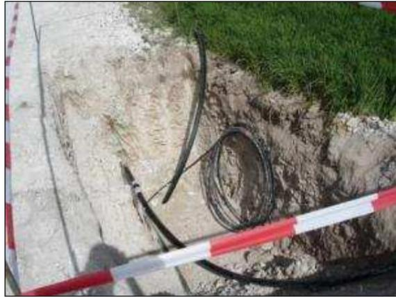
Figure 13 : Tranchée pour le passage des câbles électriques
