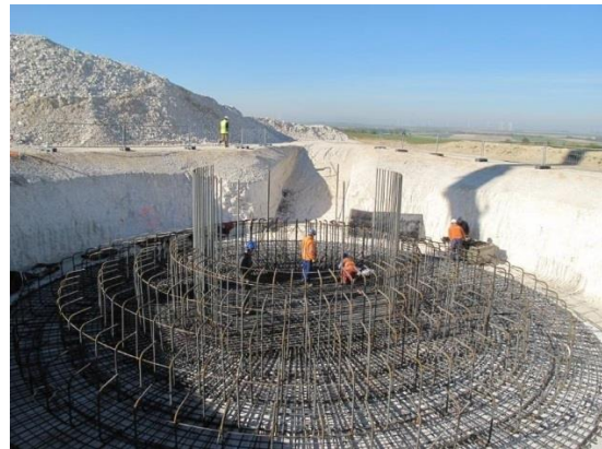
Mise en place du ferrailage
