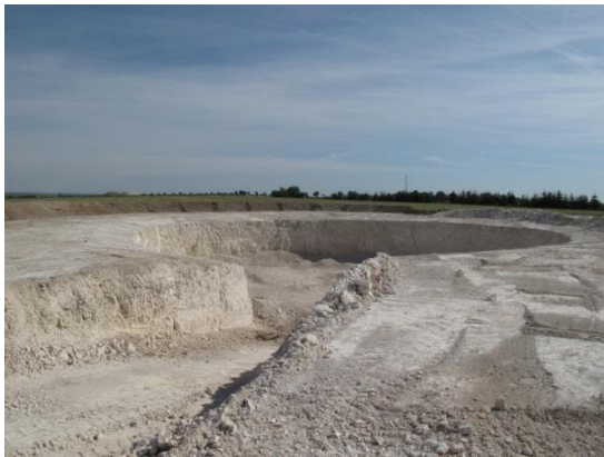
Réalisation des excavations
