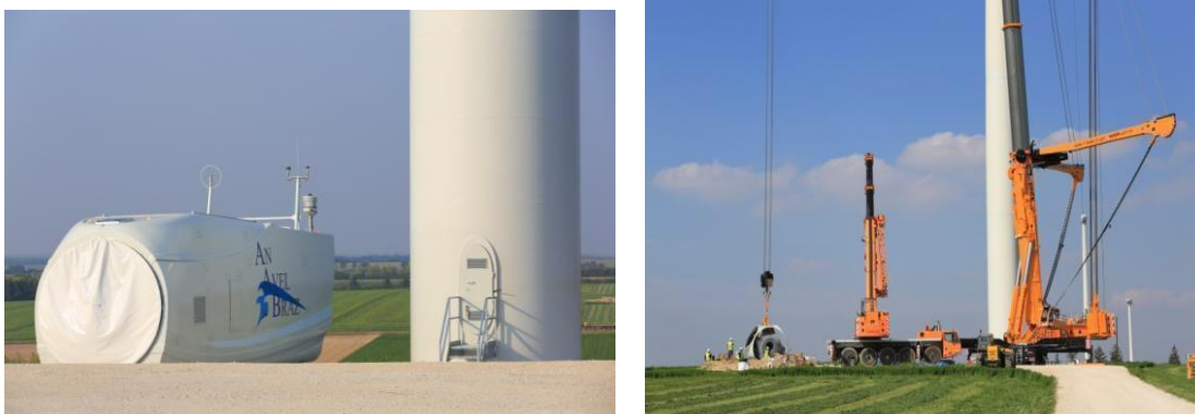
Figure 10 : Stockage de composants avant assemblage
