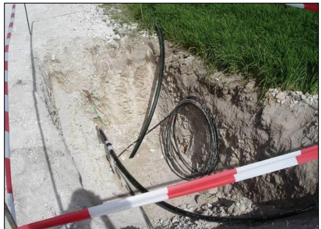
Figure 8 : Tranchée pour le passage de câbles électriques
