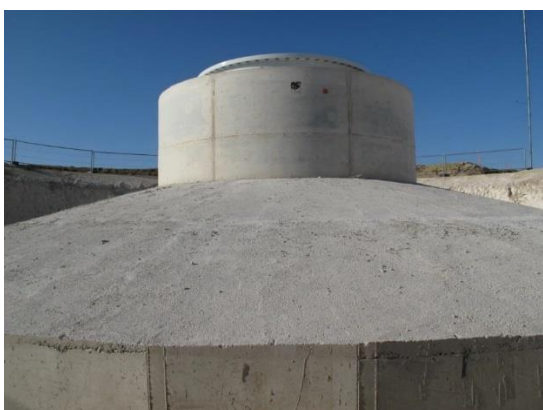
Le béton du fût est ensuite coulé
