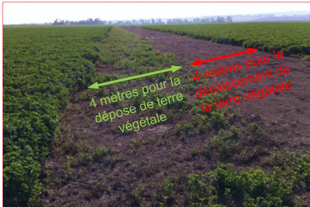
Tranchée pour le passage des câbles électriques type Rep 1A
