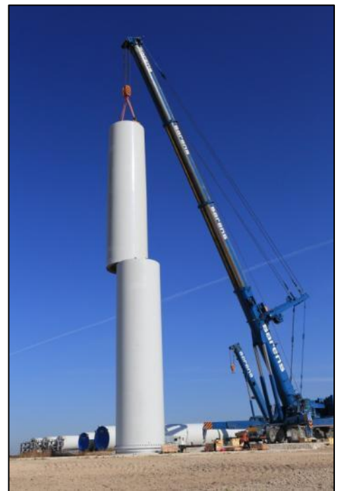
Figure 8 : Grues avant levage du moyeu
