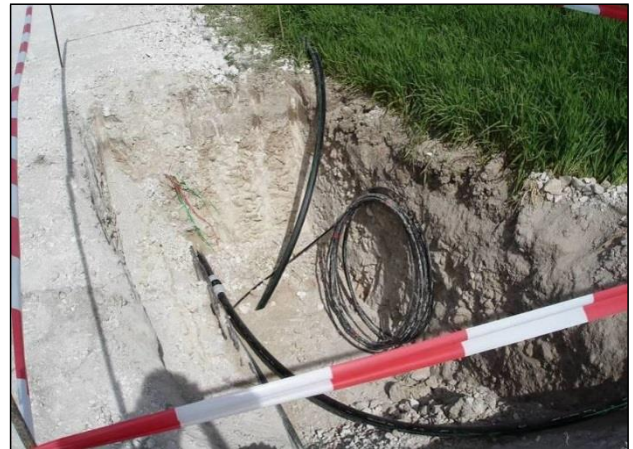
Figure 7 : Tranchée pour le passage de câbles électriques
