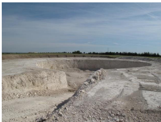
Réalisation des excavations
