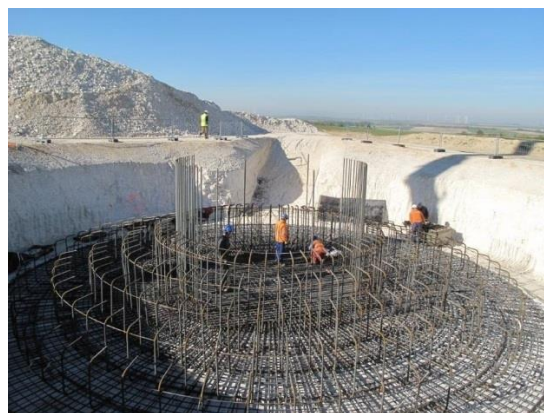
Mise en place du ferrailage
