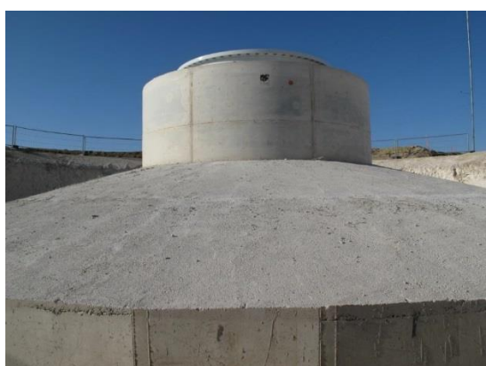
Le béton du fût est ensuite coulé
