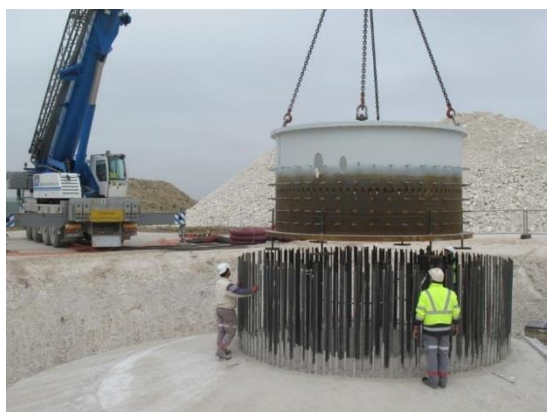
Fixation de la virole à la partie supérieure de la fondation (étape 1)
