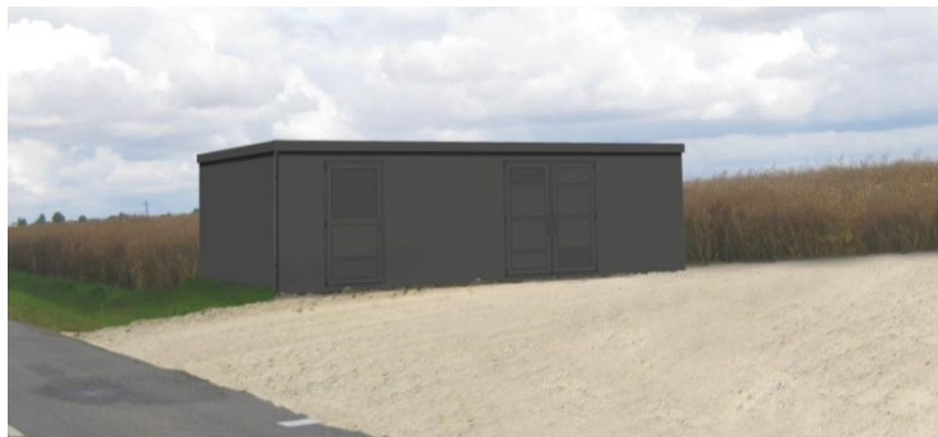
Figure 26 : exemple d'habillage d'un poste de livraison (source BE Visu)
