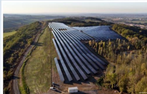
Centrale Solaire du SEQUESTRE Département du Tarn (81) Puissance électrique : 4 500 KWc Mise en service : Octobre 2013
