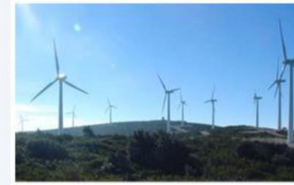
Parc de TUCHAN Département : Aude (11) Puissance électrique : 11,7 MW 18 éoliennes Mise en service : 2001-2002-2009
