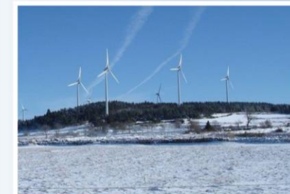
Parc de SAINT JEAN LACHALM Département : Haute Loire (43) Puissance électrique : 18 MW 9 éoliennes Mise en service : 2008
