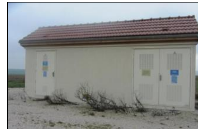
Figure 9 : Exemple de poste de livraison (Parc éolien des 4 vallées)
