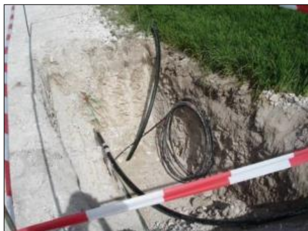
Figure 13 : Tranchée pour le passage des câbles électriques
