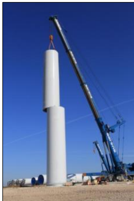
Figure 14 : Grues avant levage du moyeu
