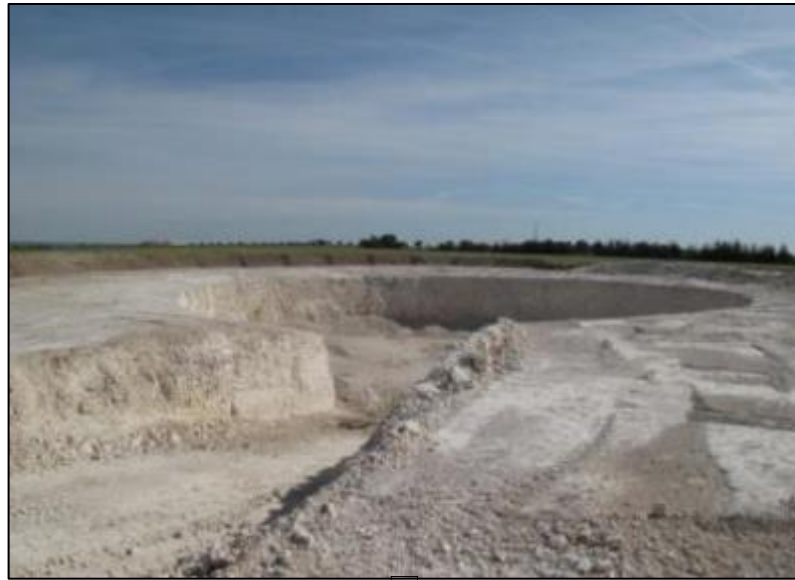
Réalisation des excavations
