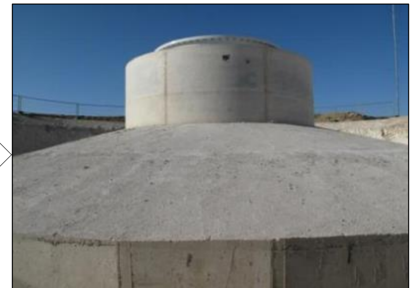
Le béton du fût est ensuite coulé
