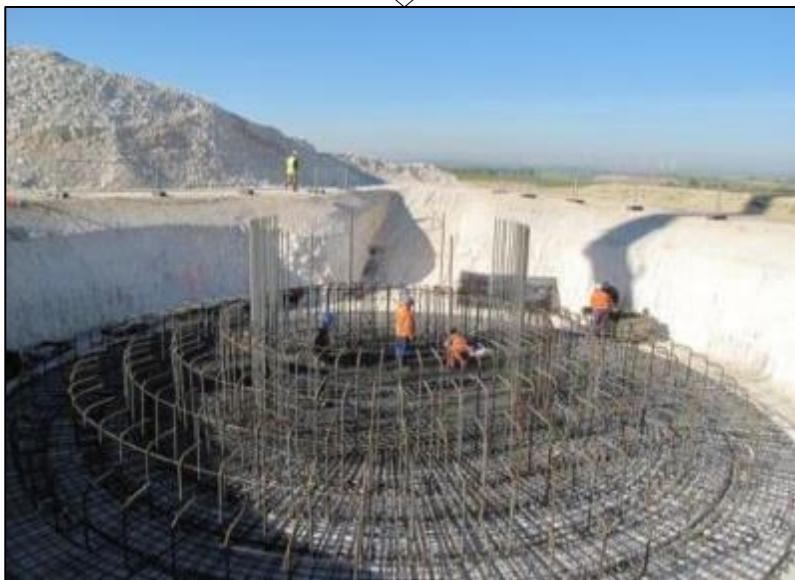
Mise en place du ferrailage
