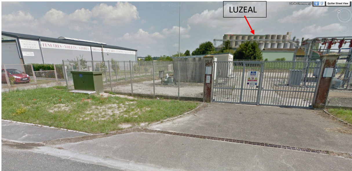
Figure 7 - Vue depuis le Nord du site, depuis la ZA Champagne, située au Sud de SEPT-SAULX
