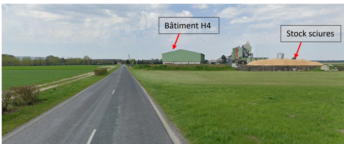
Figure 2 - Même point de vue - vue rapprochée
