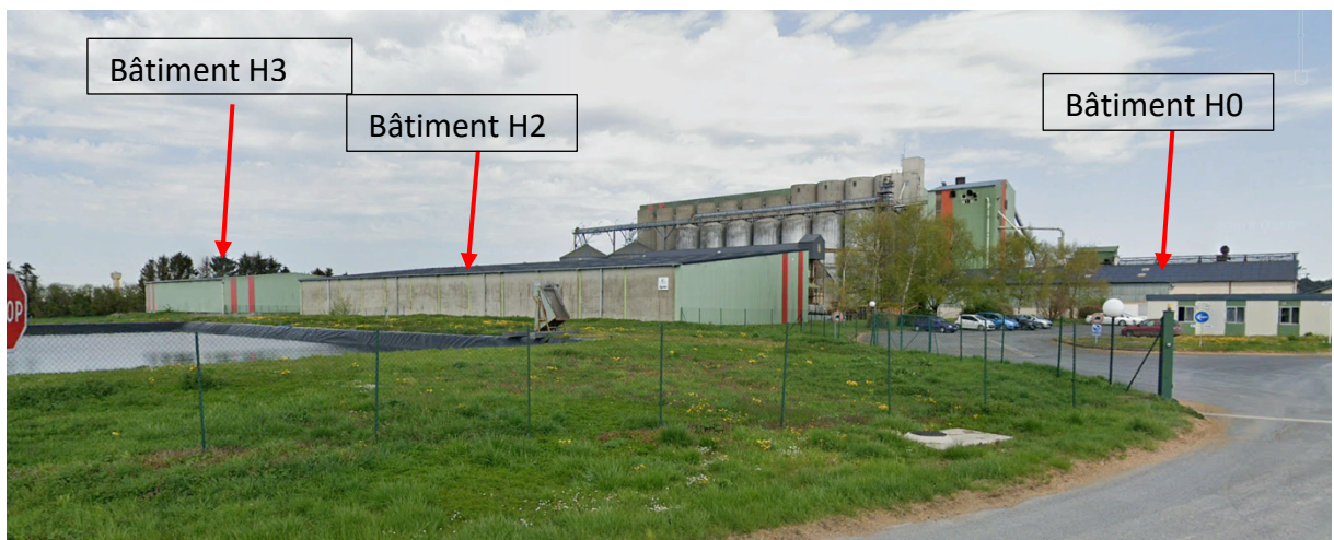
Figure 4 – Vue depuis la D8 – Côté Nord du site
