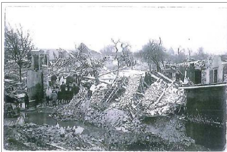
Maisons écroulées après la crue de 1910 à Tours-sur-Marne
