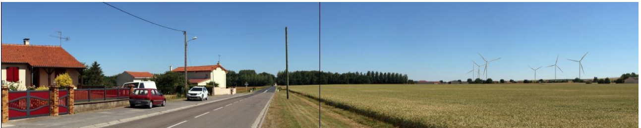
Figure 25 : Aperçu depuis la sortie sud de Pringy
