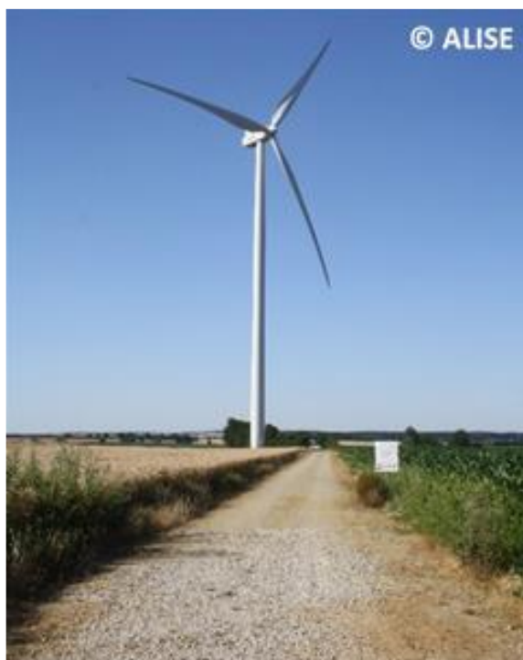
Photo 7 : Exemple de piste d'accès aux éoliennes
