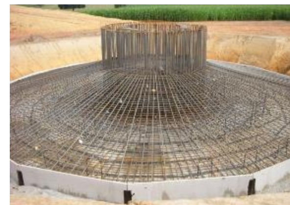
Photo 3 : Excavation et préparation de l'armature
