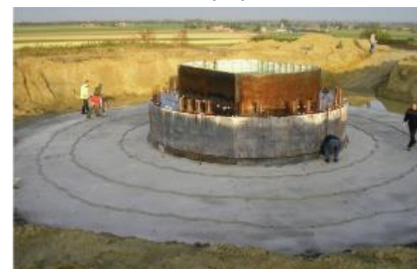
Photo 4 : Durcissement béton
