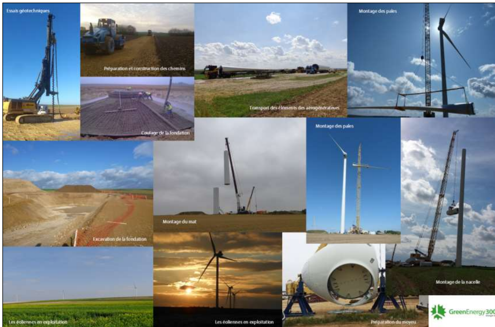
Photo 1 : Les phases de construction d'un parc éolien (Source : document interne à l'entreprise)
