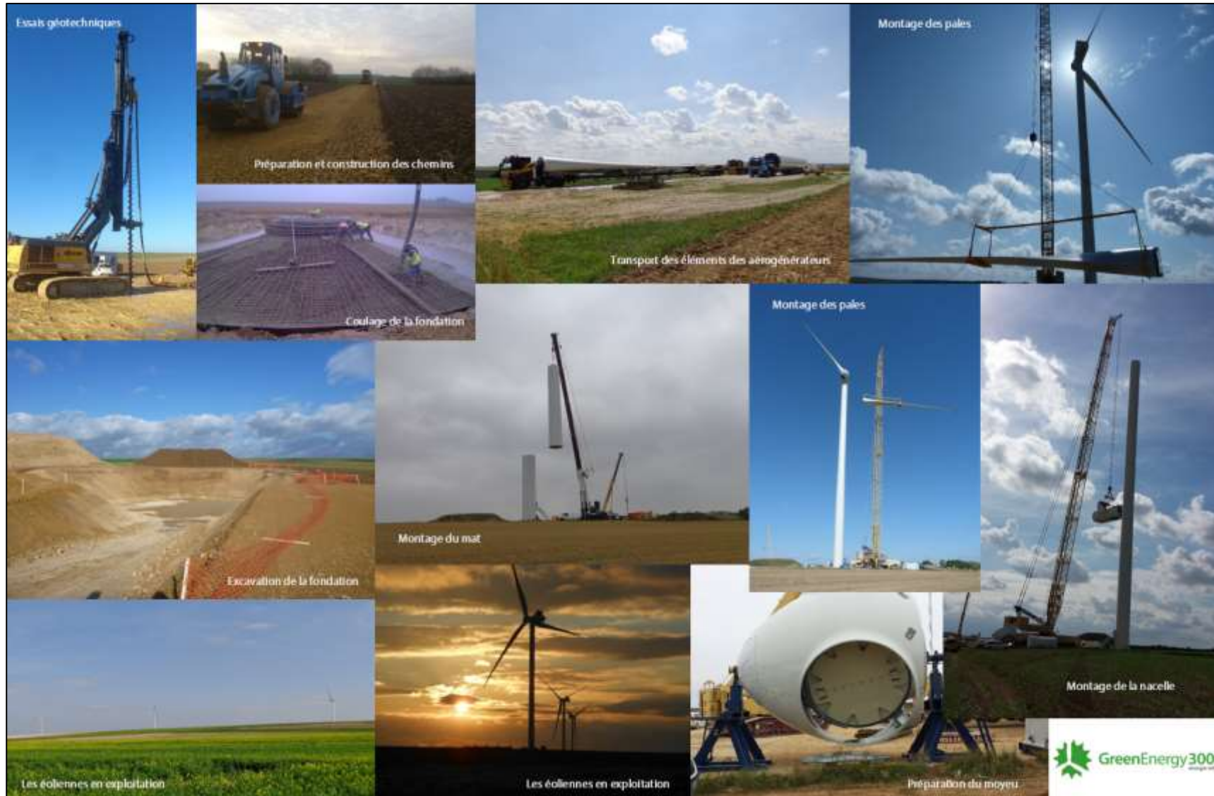
Photo 1 : Les phases de construction d'un parc éolien (Source : Green Energy 3000 GmbH)
