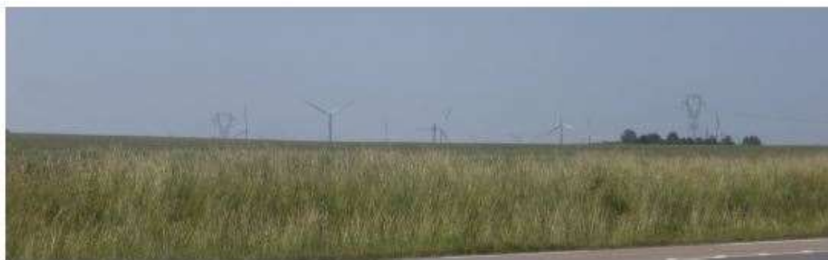
Photo 28 : Le parc éolien de Fère-Champenoise, Euvy et Corroy, depuis la nationale N4 (Source Savart Paysage, photo 64)
