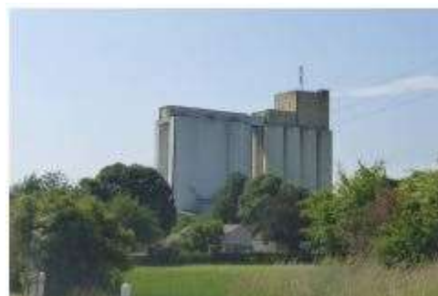
Photo 18 : Le silo de Buyy-Lettrée se dresse au-dessus des éléments de composition de ce territoire. (source : Savart Paysage, photo 26)
