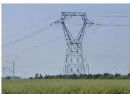
Photo 17 : Co-visibilité entre pylône éoliennes et habitations (source : Savart Paysage, photo 71)
