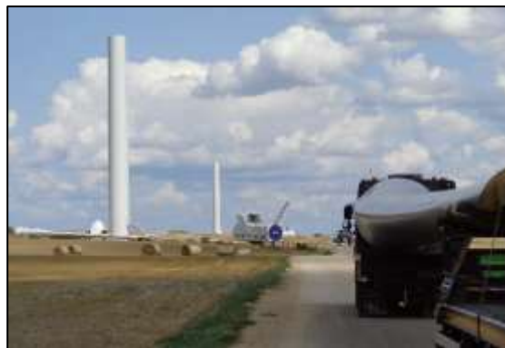
Photo 40: Acheminement d'une pale pour la construction du parc éolien de Saulces-Champenoises (Source : Green Energy 3000 GmbH)
