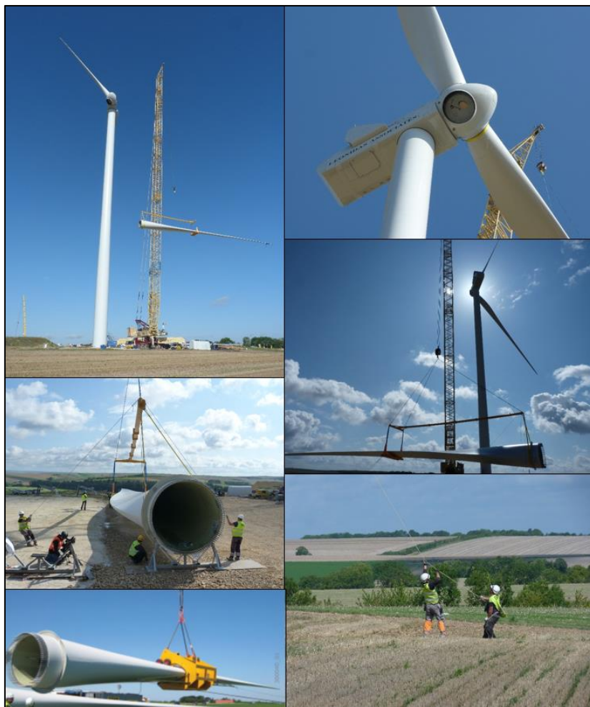
Photo 18 : Montage des pales (Source : document interne à l'entreprise, Vestas)
