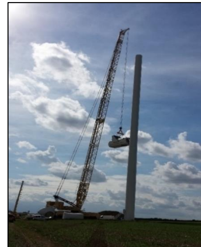
Photo 17 : Hissage de la nacelle (Source : document interne à l'entreprise)
