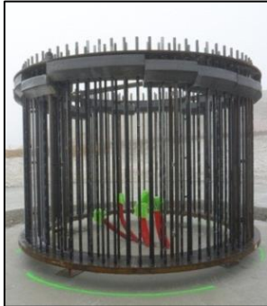
Photo 6 : Cage d'ancrage (Source : document interne à l'entreprise)
