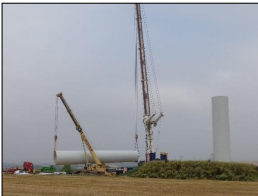
Photo 15 : Hissage de la deuxième section de la tour (Source : documents internes à l'entreprise)
