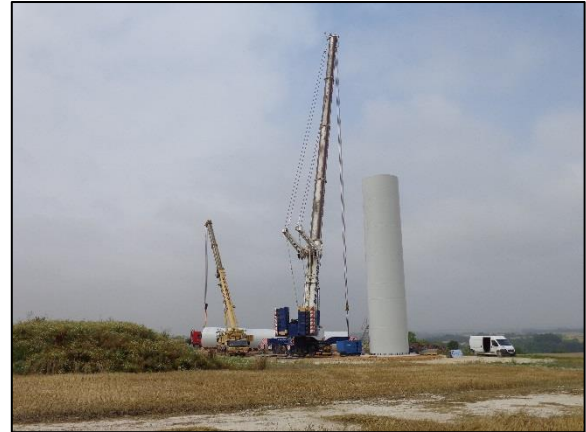
Photo 14 : Hissage de la première section de la tour (Source : documents internes à l'entreprise)
