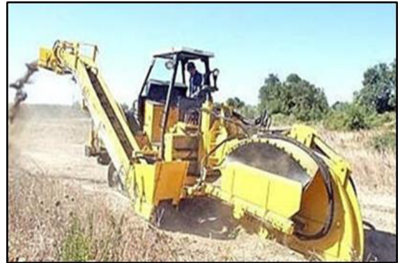
Photo 4 : Trancheuse utilisée pour la réalisation des tranchées sur environ 1 m de profondeur (Source : Vestas)
