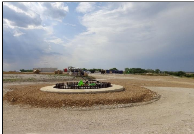
Photo 9 : Fondation au stage final (Source : document interne à l'entreprise)
