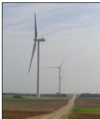
Photo 3 : Accès aux éoliennes du parc de Saulces-Champenoises (Source : document interne à l'entreprise)
