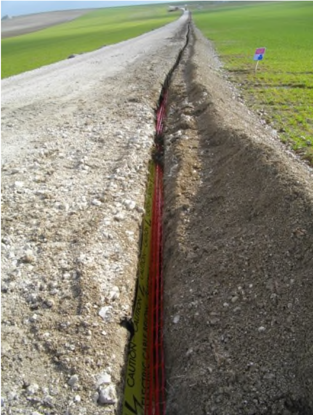
Figure 2 - Tranchée avant remblayage (Câbles et grillage posés)
