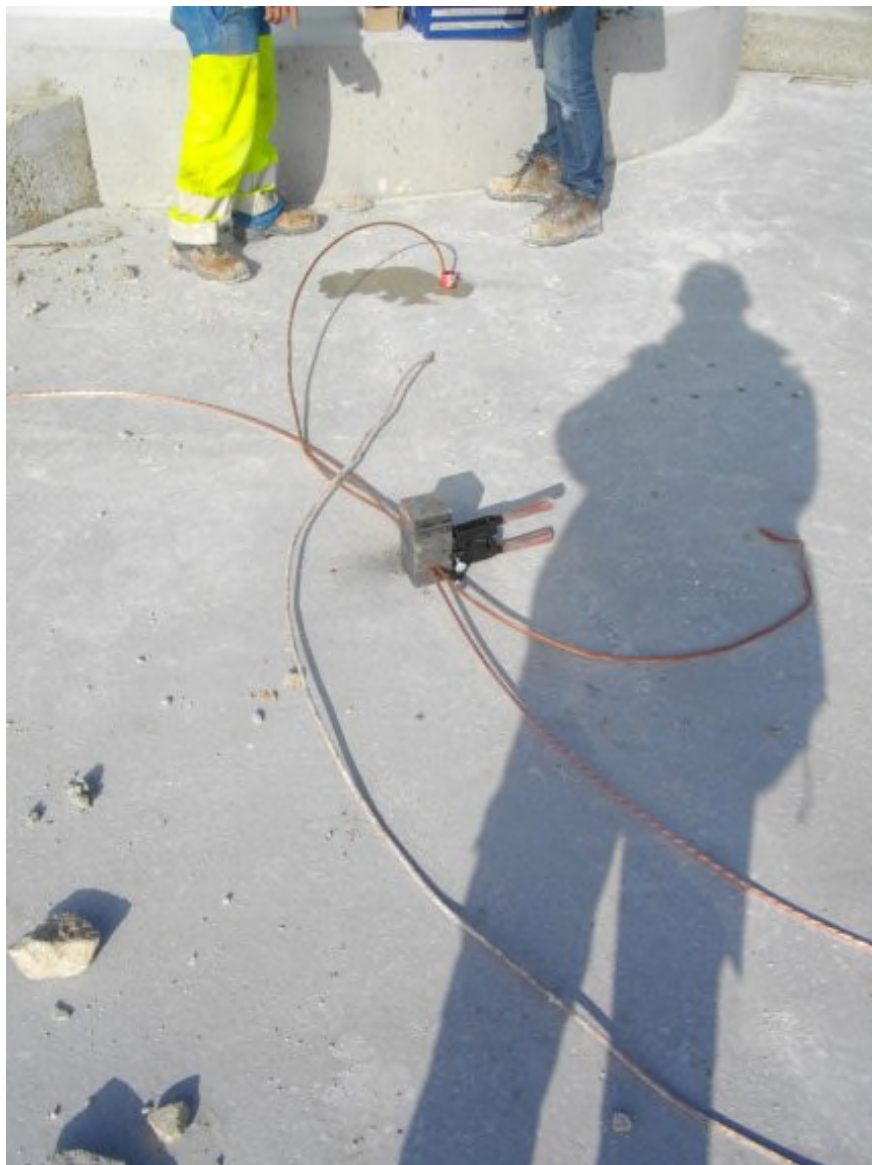
Figure 5 - interconnexion du réseau de terre
