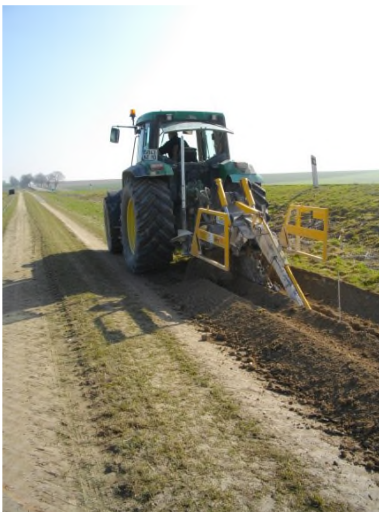
Figure 1 - Ouverture à la trancheuse
