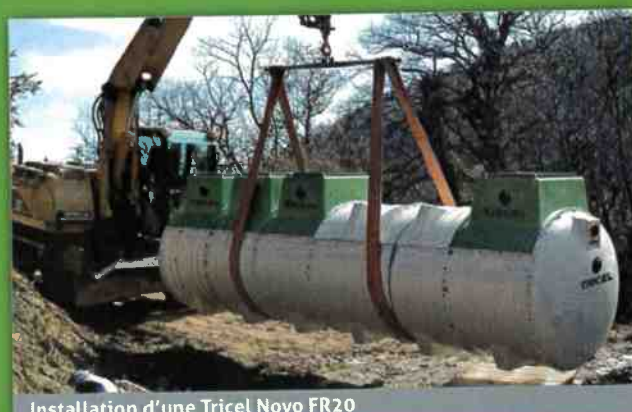
Installation d'une Tricel Novo FR20
