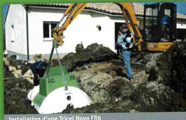
Installation d'une Tricel Novo FR6
