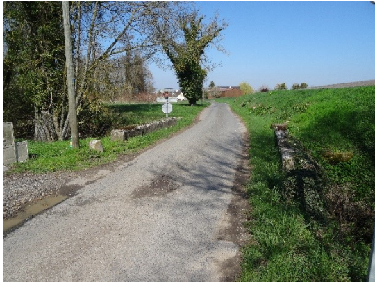
N°7 : Pont - La Boulonnerie
