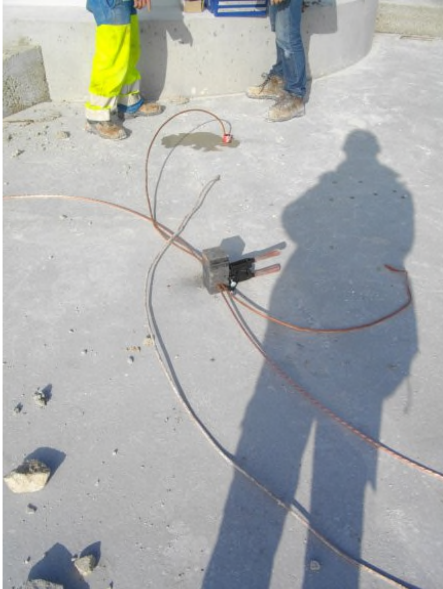
Figure 5 - interconnexion du réseau de terre
