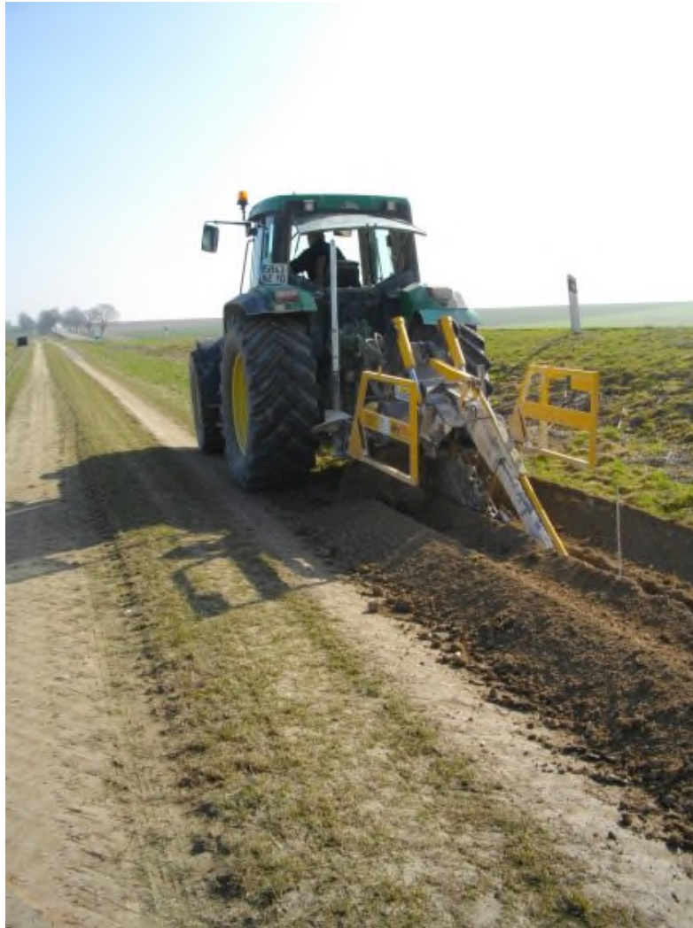
Figure 1 - Ouverture à la trancheuse
