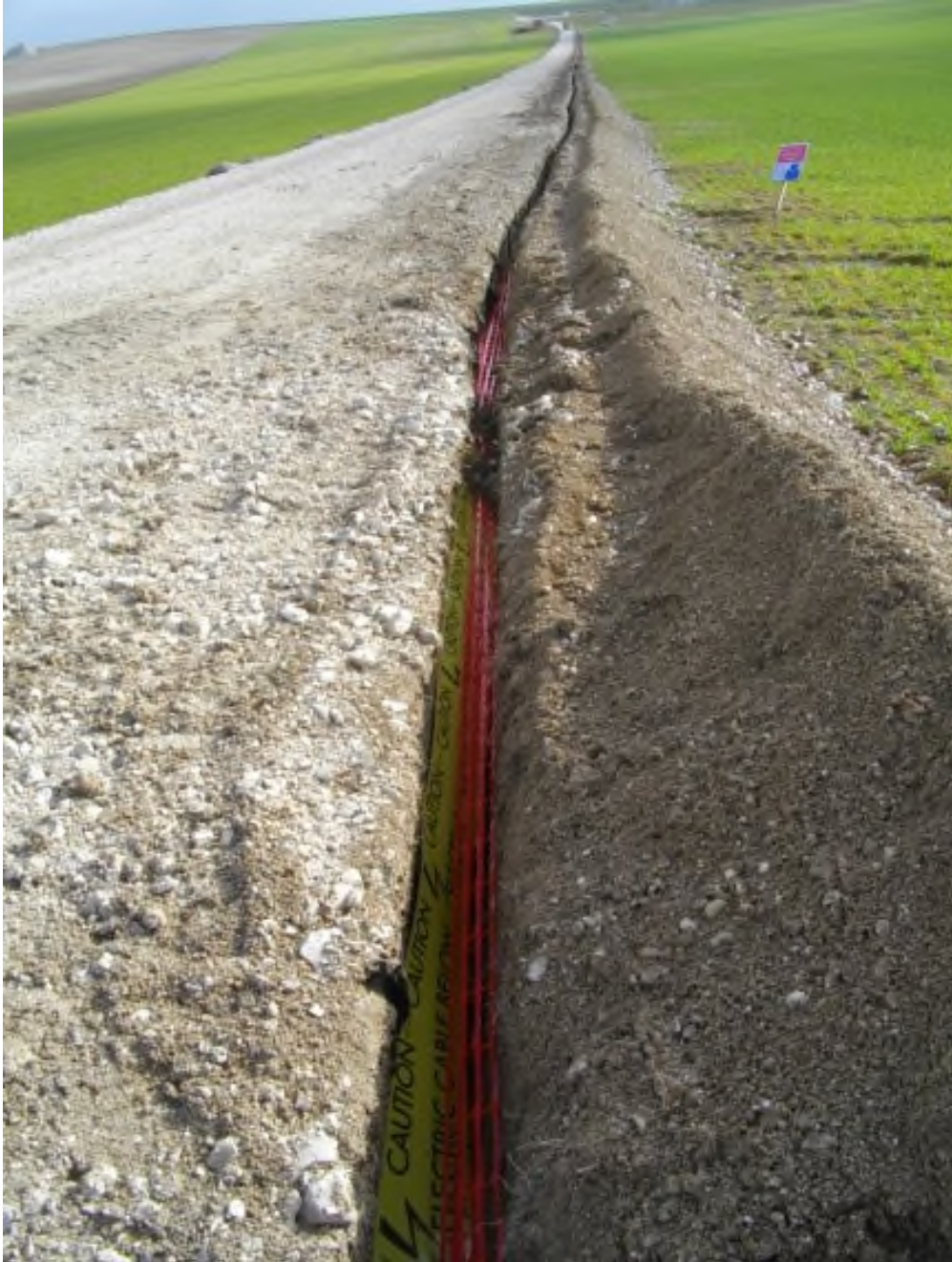
Figure 2 - Tranchée avant remblayage (Câbles et grillage posés)
