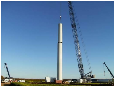
Photo 8. Montage des éléments de la tour
