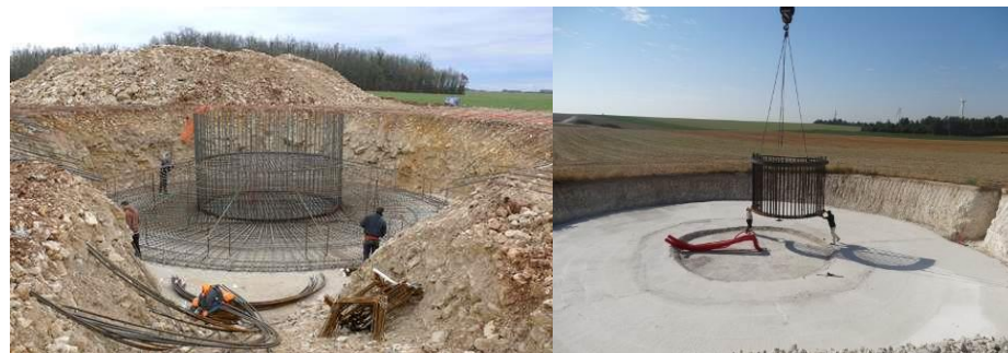
Photo 4. Exemple de mise en place d'une fondation
