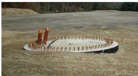
Photo 3. Fondation d'éolienne une fois remblayée
