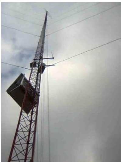
Photo 2. Mat 5102 - 100m. Est équipé de quatre anémomètres à 67, 80, 93 et 100 mètres
