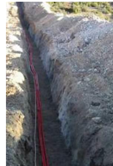
Photo 5. Tranchée pour la mise en place des câbles du réseau interne
