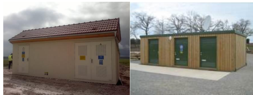
Photo 6. Exemples de poste de livraison de parcs éoliens développés en milieu rural
