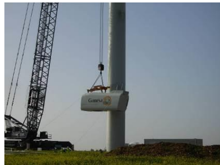
Photo 9. Montage de la nacelle
