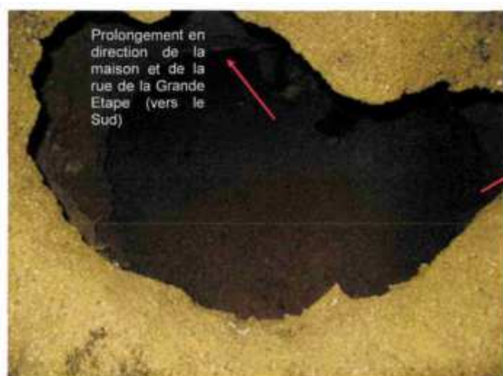
Intérieur de la cavité
