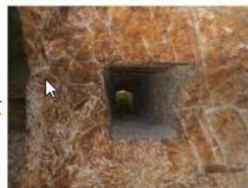
Conduit d'aération Caves Joseph-Perrier
