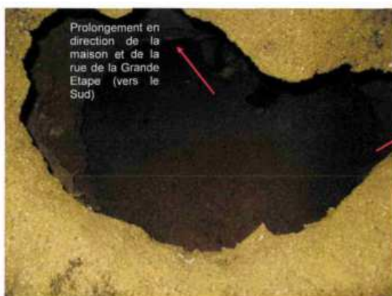
Intérieur de la cavité
