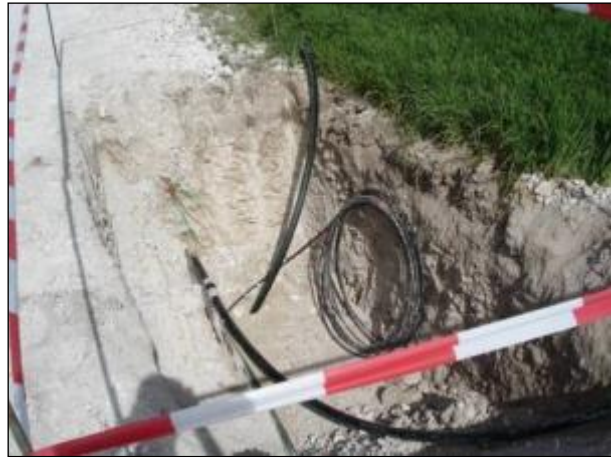
Illustration 4 : Tranchée pour le passage des câbles électriques
