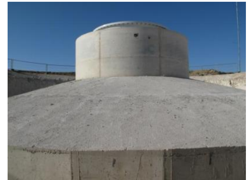
Le béton du fût est ensuite coulé
