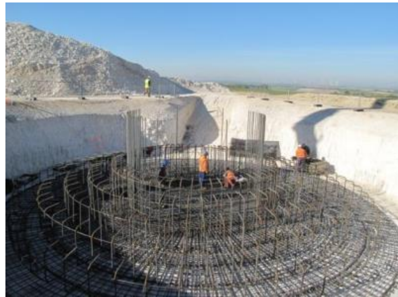
Mise en place du ferrailage
