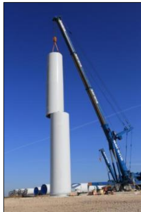
Illustration 5 : Grues avant levage du moyeu
