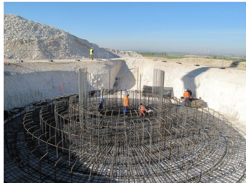
Illustration 4 : Mise en place du ferrailage
