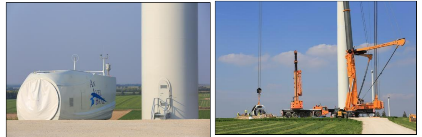
Illustrations 10 et 11 : Stockage de composants avant assemblage
