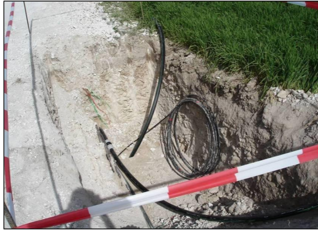
Illustration 8 : Tranchée pour le passage des câbles électriques
