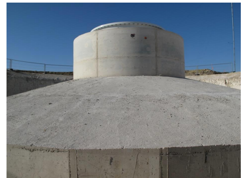
Illustration 7 : Le béton du fût est ensuite coulé
