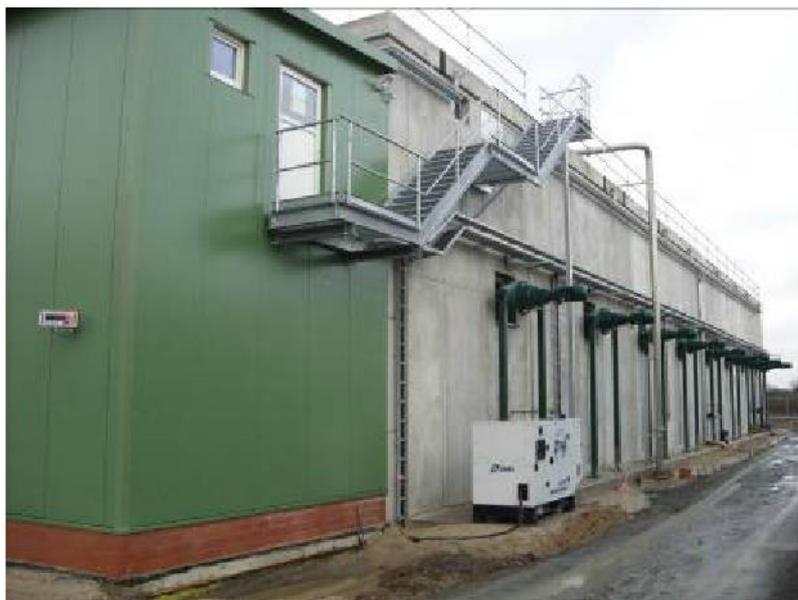
Figure 4 : Exemple de digesteur sec LARAN® (source Strabag)
