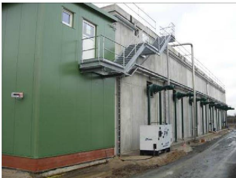
Figure 10 : Exemple de digesteur sec LARAN® (source Strabag)
