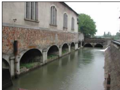
Canal de fuite de l'usine
