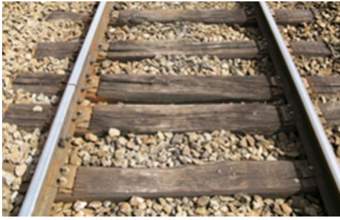
Rails courts sur traverses bois
