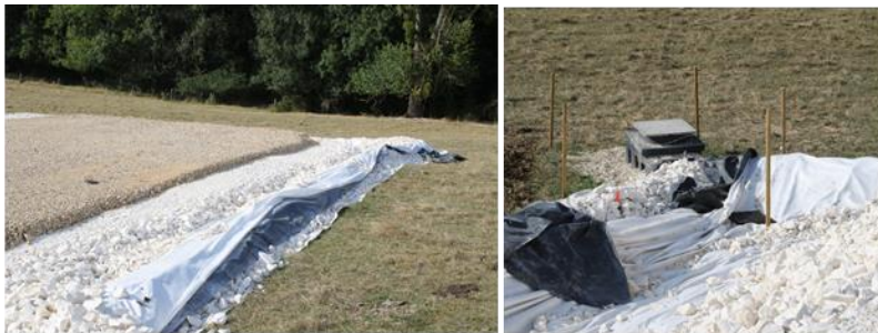
Ci-contre, vues d'une plateforme étanche associé à un déshuileur . Chantier LSV RTE - 2015 – Source : © J.MIROIR-ME
