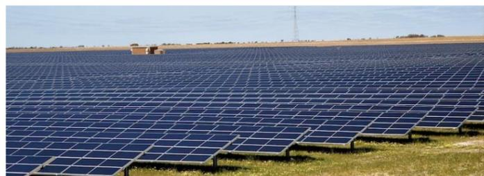
*Figure 2 : Parc solaire de Lone Valey (30 MW, traceur Exosun) - Californie, USA*
