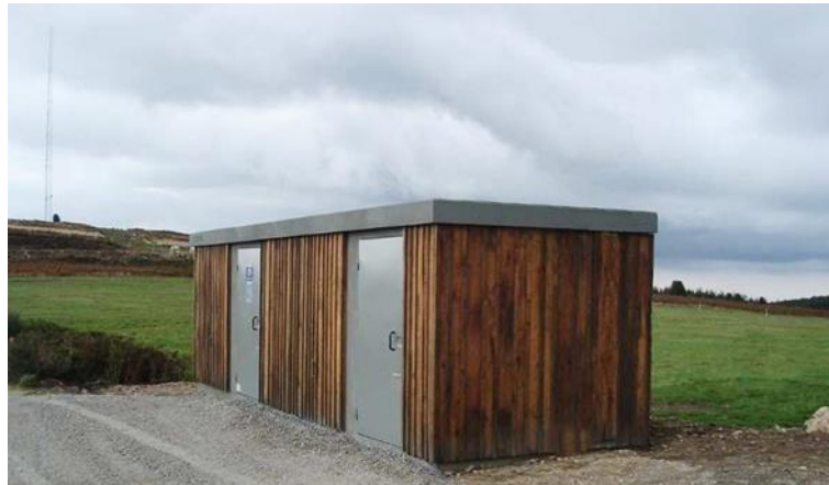
Figure 5 : Exemple de poste de livraison habillé d'un bardage bois (parc éolien de Margnes / Tarn) (source : Atelier de l'Isthme, 2019)
