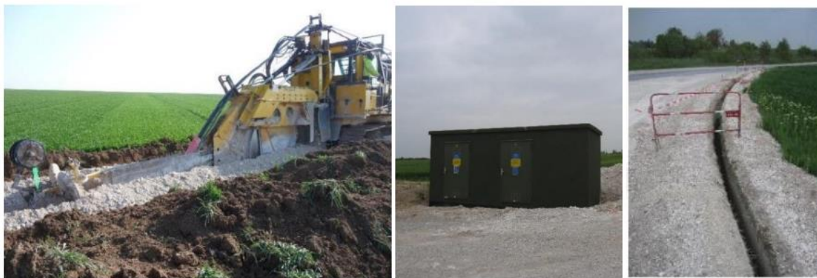
Figure 8 : photographie de l'installation du raccordement électrique
