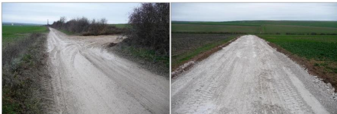
Figure 4 : photographies des aménagements et/ou construction de route
