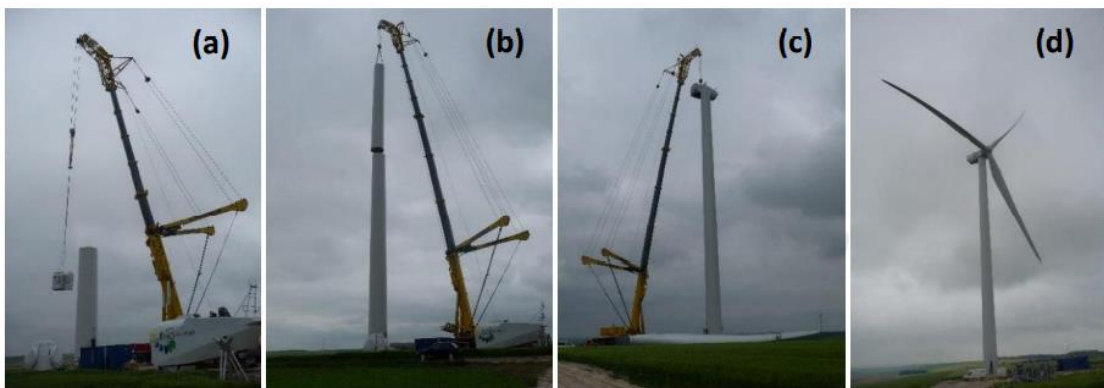
Figure 7 : photographie de l'installation des éoliennes
