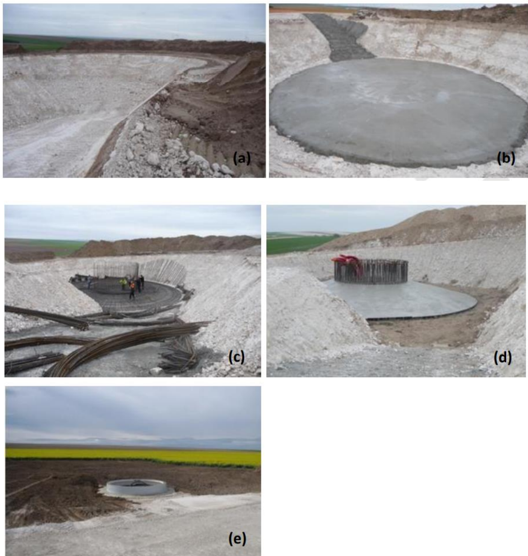
Figure 5 : photographie de l'installation des fondations
