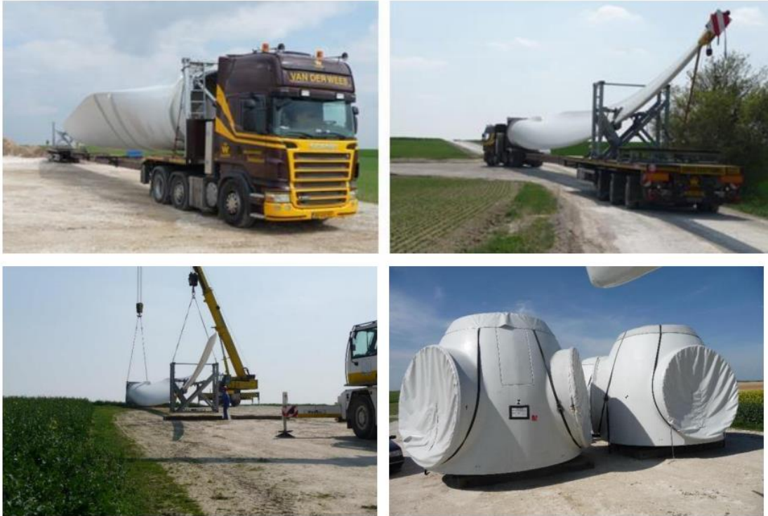
Figure 6 : photographie de l'acheminement par camion des composants des éoliennes
