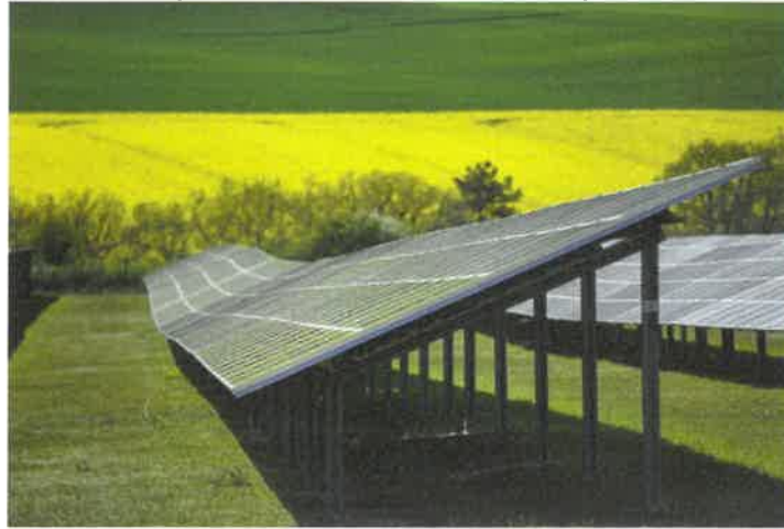
Figure 6 : Panneaux sur structure gabion
