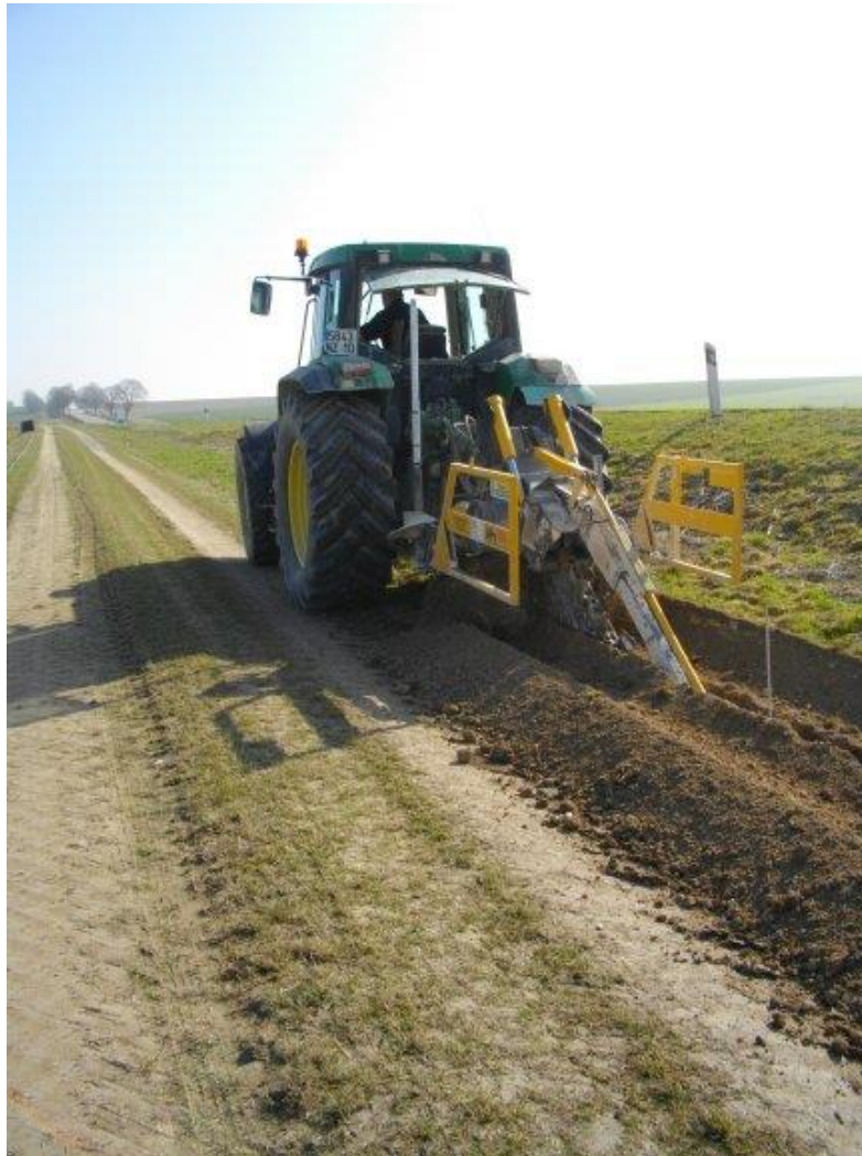
Figure 1 - Ouverture à la trancheuse
