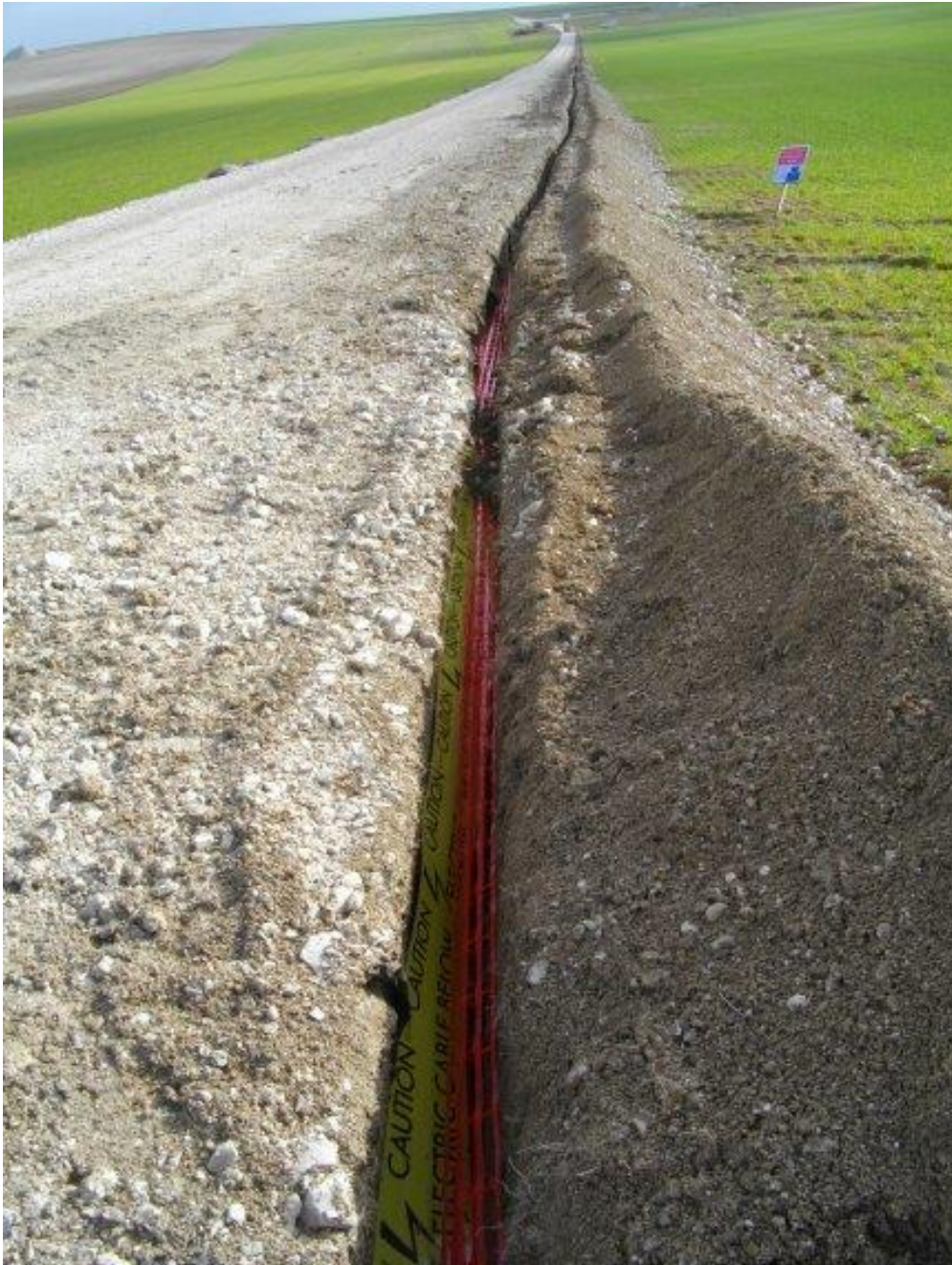
Figure 2 - Tranchée avant remblayage (Câbles et grillage posés)
