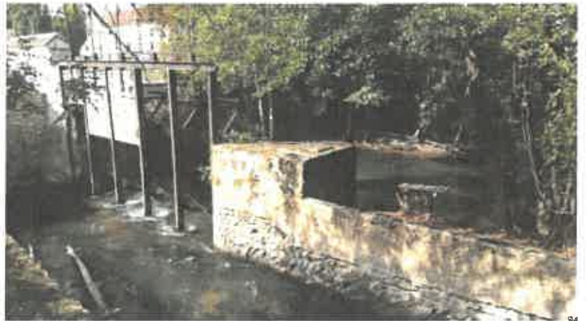
Photo des ouvrages (vannes et mur maçonné) du Moulin de Court
