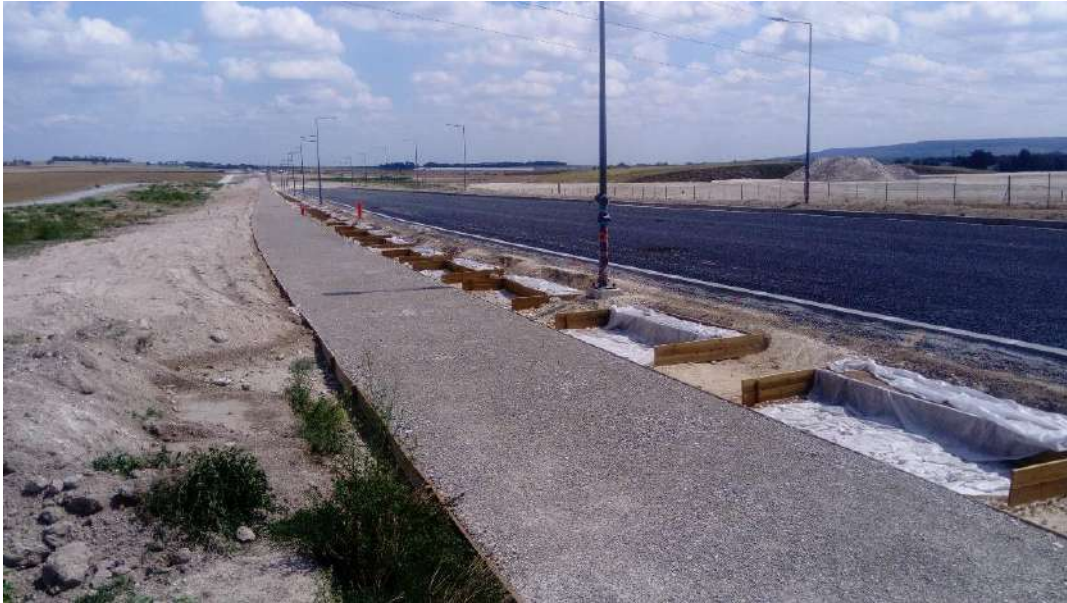
Aménagement des noues le long de la voirie primaire (juillet 2017)
