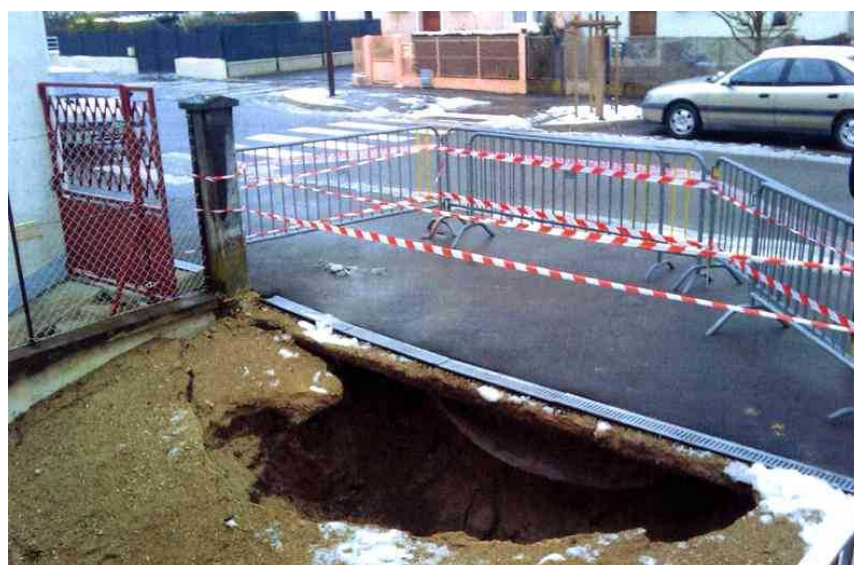
Effondrement rue Camp d'Attila à Châlons-en-Champagne
