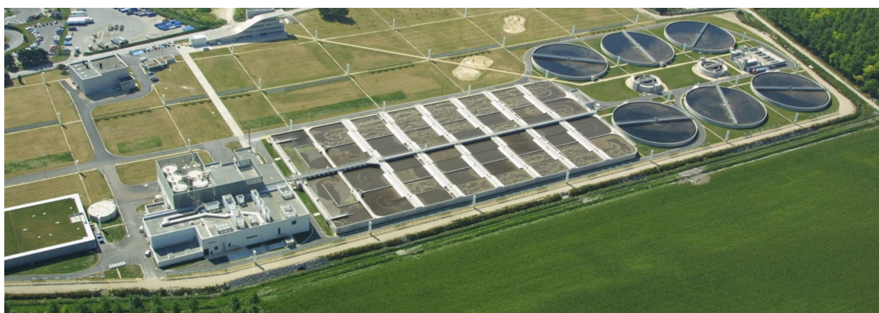
Figure 4 : Photographie aérienne de la STEP de Reims
