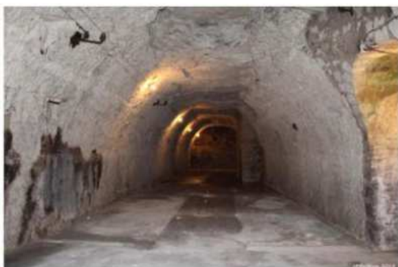
Illustration 7 : Galerie n°13 avec son extrémité Sud murée (photo : JP Batteux). Vue vers le SW
