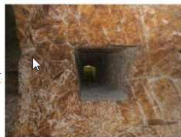
Conduit d'aération Caves Joseph-Perrier
