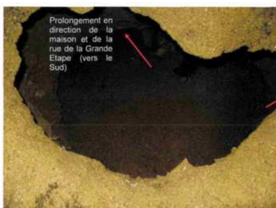
Intérieur de la cavité
