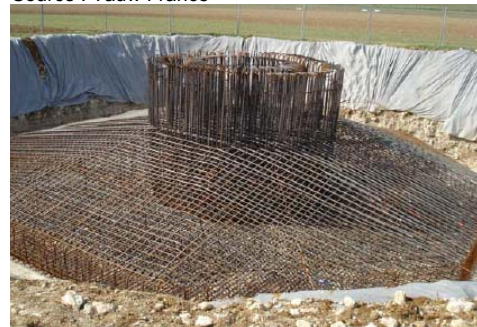
Figure 6 : Photo du ferrailage d'une fondation type
