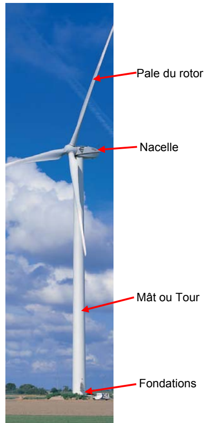
Figure 6 : Description d'une éolienne
