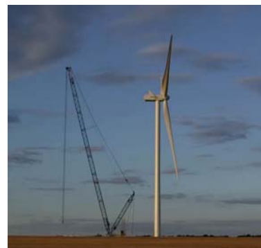
Figure 10 : Grue de montage et élévation du rotor - Source : Tauw France
