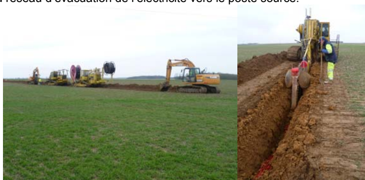
Figure 11 : Photo d'une tranchée pour l'enfouissement des câbles électriques - Source : Tauw France
