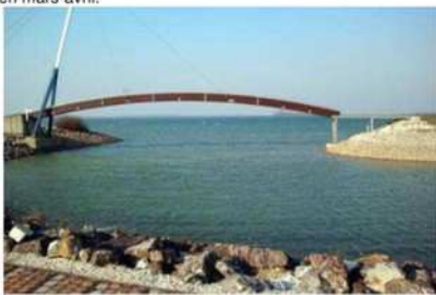
Le lac du Der stocke actuellement près de 127 millions de m 3 d'eau. A la fin du mois de novembre, la digue de Giffaumont et son ouvrage transversant, la galerie de la Droyes, ont été soigneusement inspectés.
