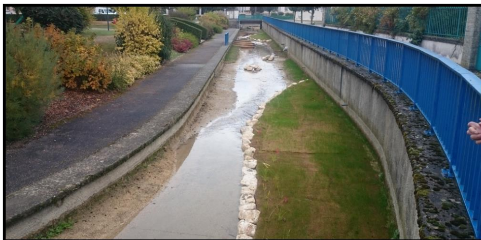
Figure 3 : Exemple de banquettes végétales implantées à Fresnes-en-Woëvre (Fluvial.IS, 2016-2018).
