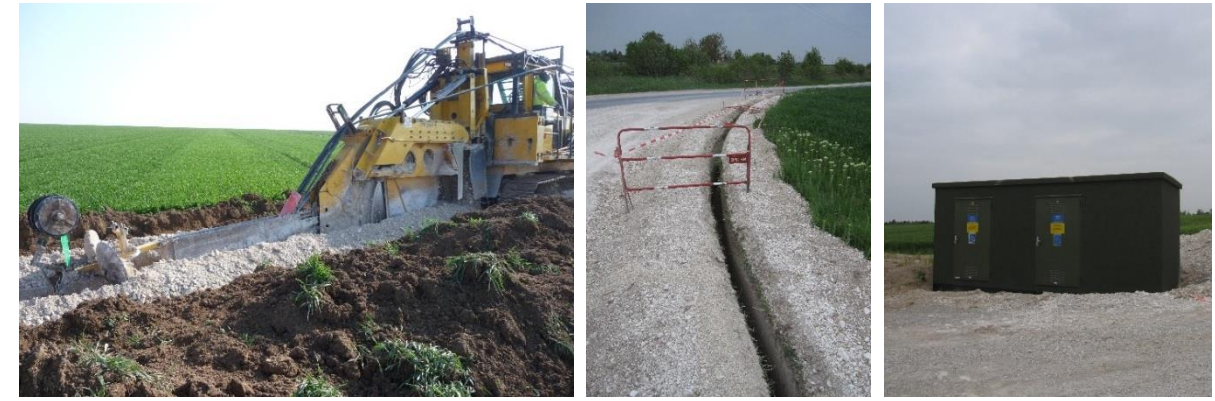
Photo 1. Illustration d'une trancheuse en action, d'une tranchée et d'un poste de livraison
